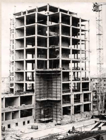
▲ ВНИИС, 70-е годы. Этапы строительства. Вид со стороны ул. Среднемосковская
